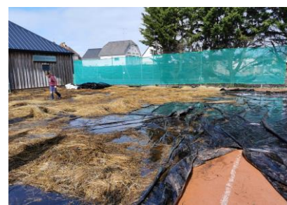
Réfection de la terre battue
